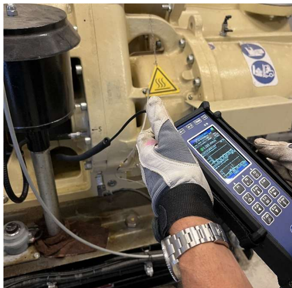
Måling på luftkompressor
